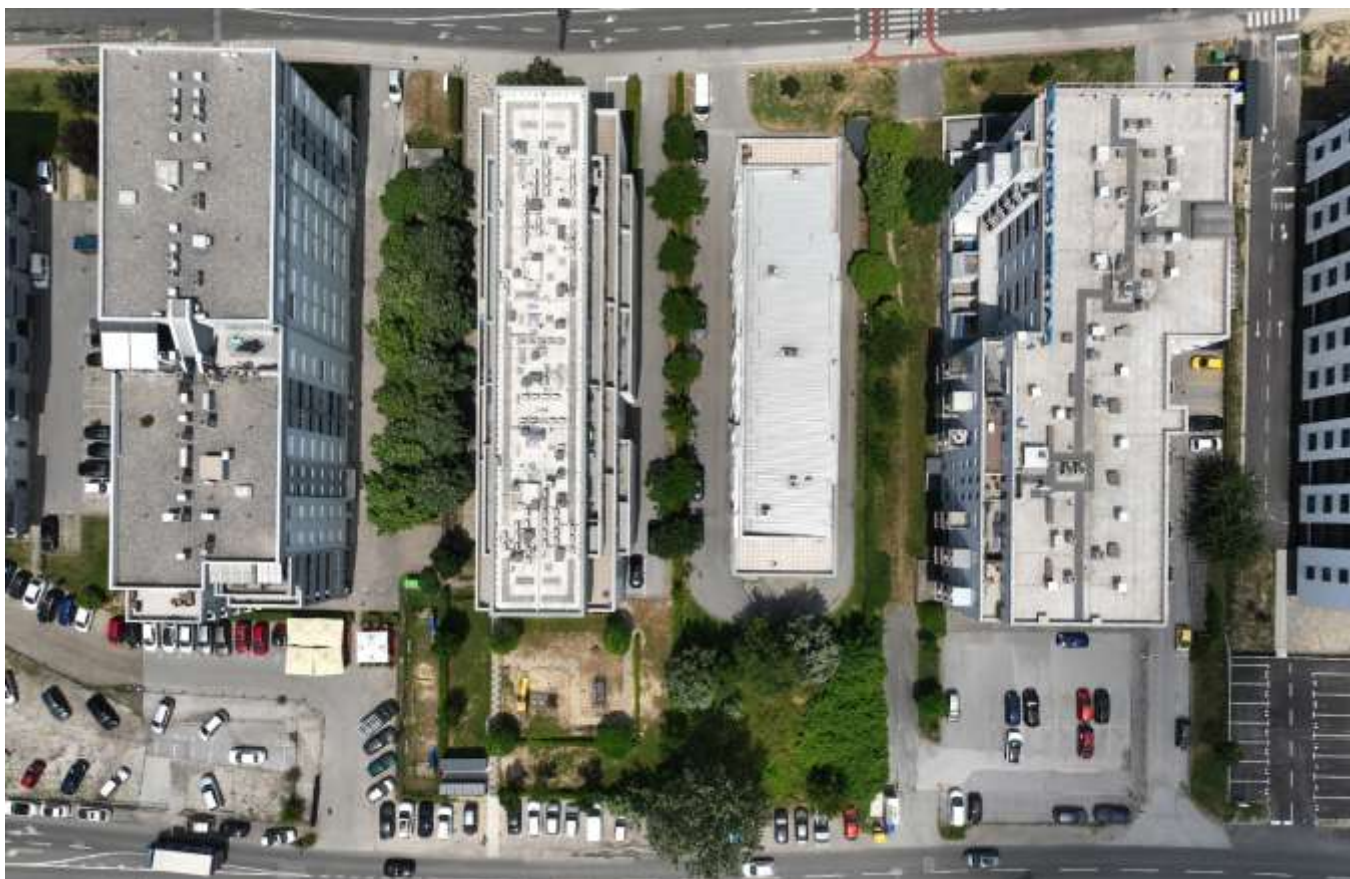
Sl. 22. Zbijene zgrade na Jaruščici
